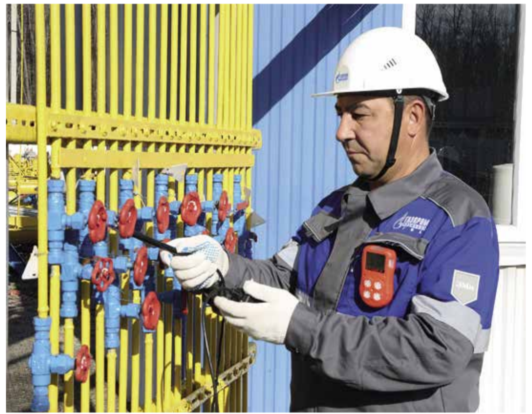
Контроль за герметичностью технологических соединений – залог безопасного проведения ремонтных работ
